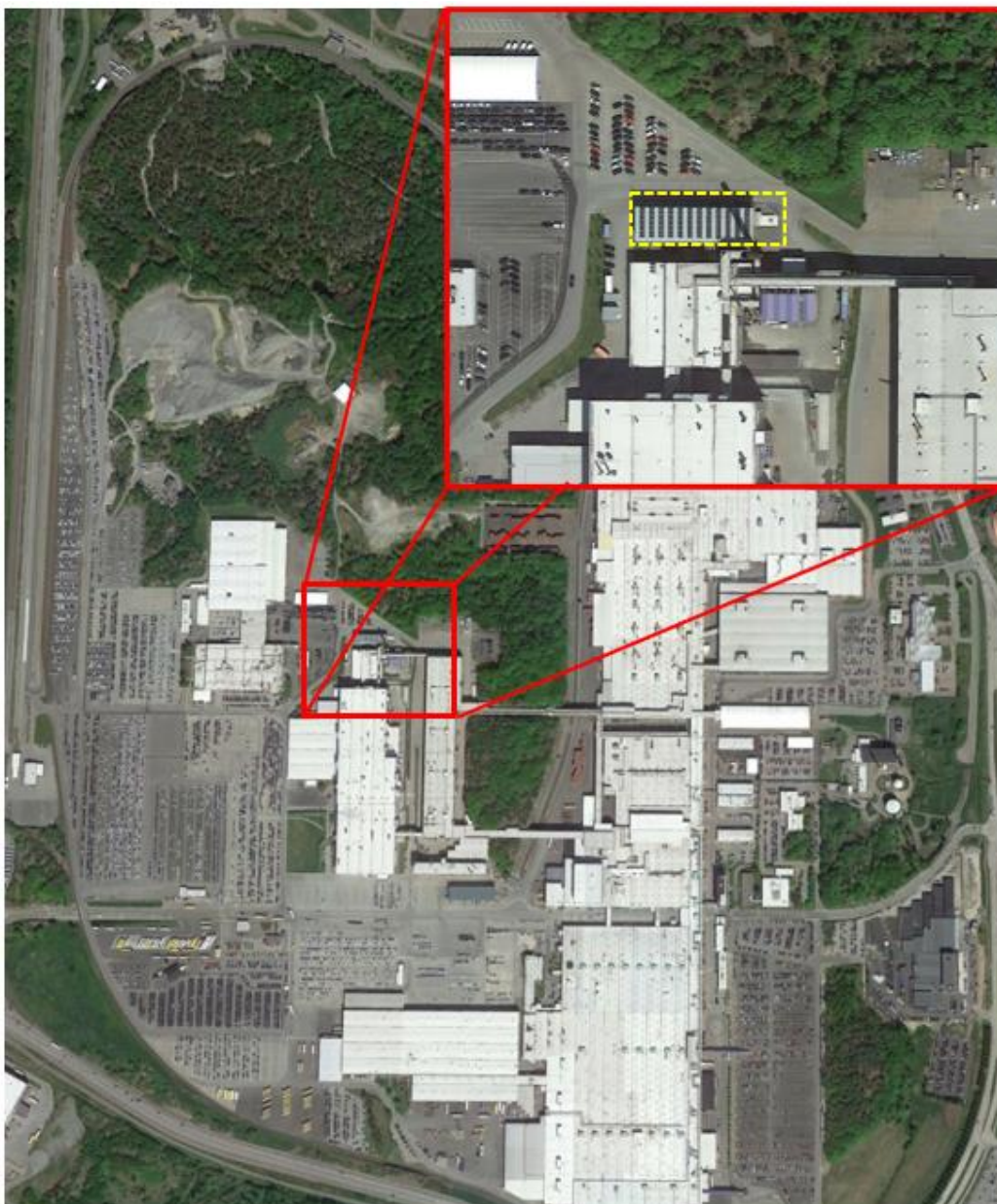
Figur 10. Placering av kylanläggning med ammoniak inom Volvo Cars fabrik i Torslanda
